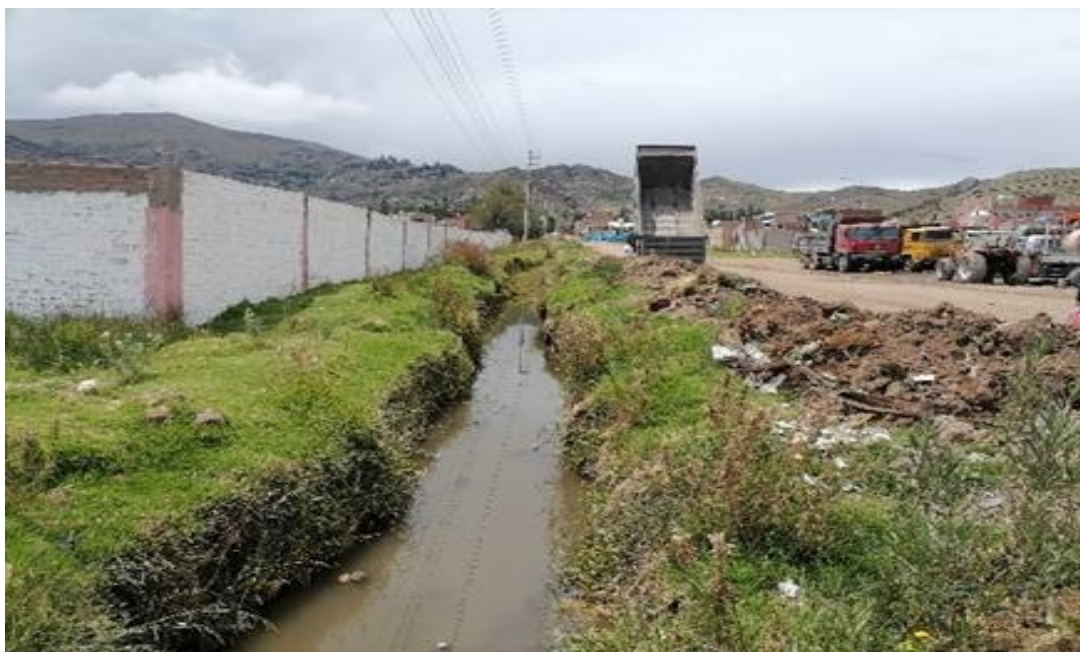
FIGURA N°03: TRAMO CRÍTICO EN EL CAUCE DEL RIO HUACUYO COLMATADO y DIQUE DETERIORADO AGUAS ABAJO DEL TRAMO DE LA CARRETERA YUNGUYO - UNICACHI, DEL AMBITO JURISDICCION DEL DISTRITO DE UNICACHI, PROVINCIA DE YUNGUYO - PUNO.
